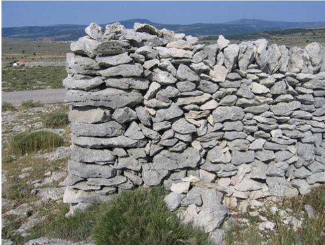
Detall d'un mur d'assegador. Els pastors i en general la població rural de la zona dels ports, construeix i manté aquests murs que configuren un paisatge agropecuari molt particular. (J. Seguí, 2005)
