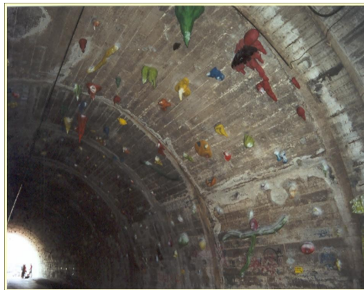
El túnel de Foixarda es utilitzat per més d'un centenar d'escaladors a diari. Els usuaris habituals s'han encarregat de la transformació de l'espai durant més de 20 anys. Actualment, després de molts anys de negociació s'ha reconegut com a parc d'escalada públic.
